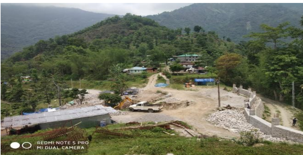
मङ्सारी मगरजोडको पुनर्निर्माण कार्य भइरहेको दृश्य
